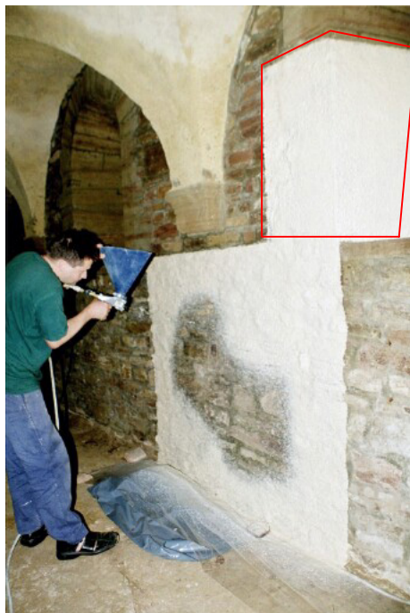
Abbildung 1: Auftragen der Kompresse mit einer Trichterpistole (rot umrandeter Bereich bemustertes Sandsteingewände)
